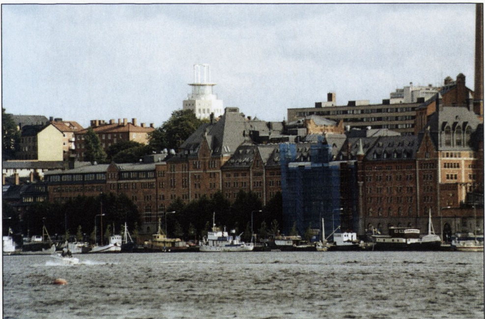
Figure 6.1: Münchenbryggeriet on Söder Mälärstrand (Negussie, 2001).
